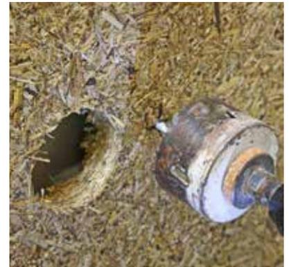
Einschneiden der Öffnung mit Bohrkronen
