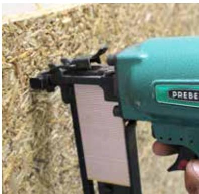
Befestigen mit Breit Rückenklammern mit Setzgerät
