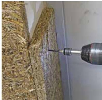
Befestigen mit Flachkopfschrauben
