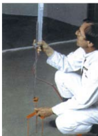
Měření výšky potěru před rozlíváním
