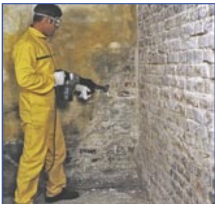
1. Odstraňování staré zasolené omítky
