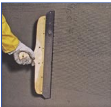
5. Vodorovné zdrsnění povrchu základní sanační omítky maxit san Grund
