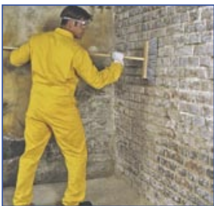
2. Očistění povrchu zdiva od prachu a hrubých nečistot
