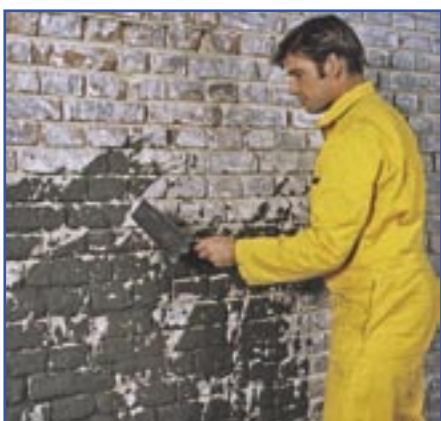
4. Provedení cementového prostřiku maxit san Vorpritz na 50 % povrchu zdiva
