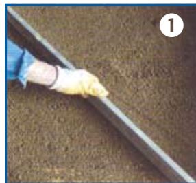
Urovnat povrch drenážního betonu rovnací lať
