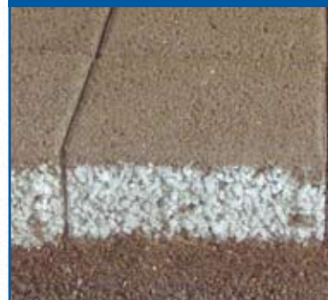
Hotová drenážní plocha
