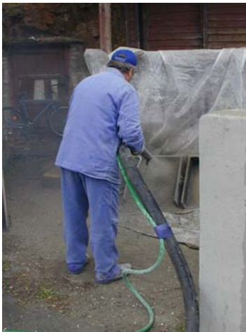
Obr. 3 Výroba zkušební desky
