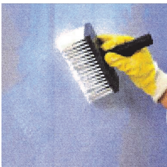
Obr.1 Navlhčení podkladu.
