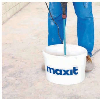
Obr.2 Namíchání hydroizolačního nátěru.
