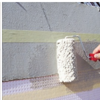
Obr.3 Nanášení 1. vrstvy hydroizolačního nátěru.
