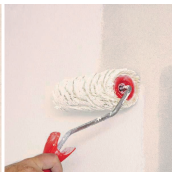
Obr.4 Provedení nátěru barvou.
