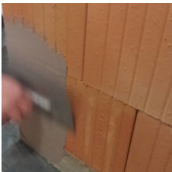
1. hydroizolace stěn pod obklady
