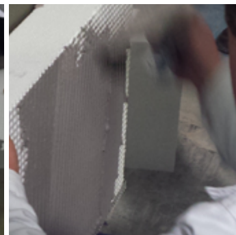
3. lepidlo na soklové, XPS a perimetr 4. armovací stěrka pro sokly s dlouhou životností
