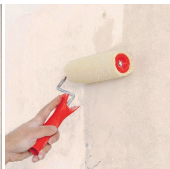
Obr.3 Provedení penetračního nátěru.
