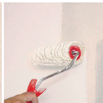
Obr.4 Provedení nátěru barvou.
