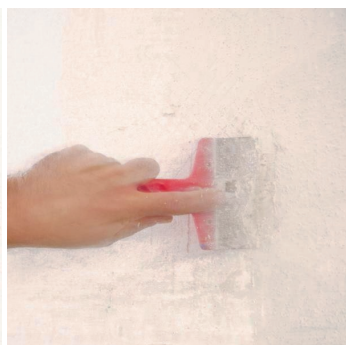
Obr.2 Odstranění nesoudržných vrstev.
