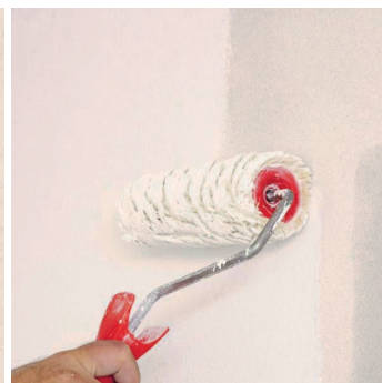
Obr.4 Provedení nátěru barvou.
