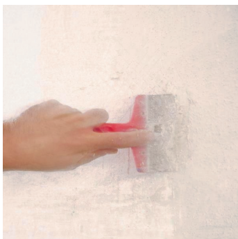
Obr.2 Odstranění nesoudržných vrstev.
