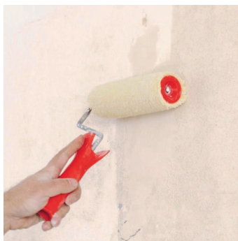
Obr.3 Provedení penetračního nátěru.
