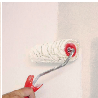
Obr.4 Provedení nátěru barvou.
