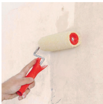
Obr.3 Provedení penetračního nátěru.
