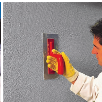
Obr.3 Vyhlazení podkladní omítky.
