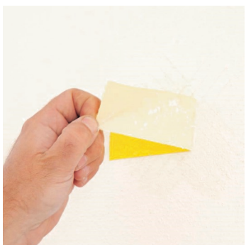
Obr.1 Příp. zkouška přídržnosti podkladních vrstev.
