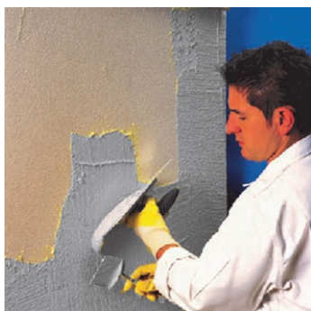
Obr.2 Nanesení vhodné podkladní stěrky nebo omítky.
