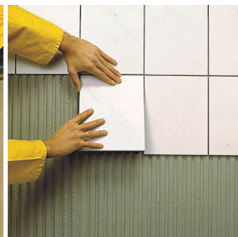
Obr.3 Lepení obkladů nebo dlažby.
