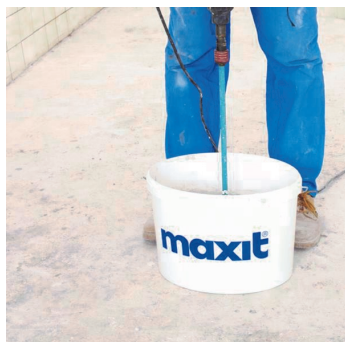
Obr.2 Namíchání lepidla míchadlem.
