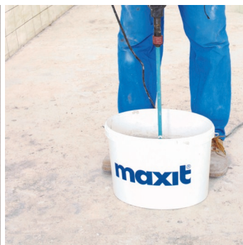
Obr.3 Promíchání penetračního nátěru.
