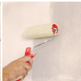
Obr.4 Provedení penetračního nátěru v 1 nebo 2 vrstvách.
