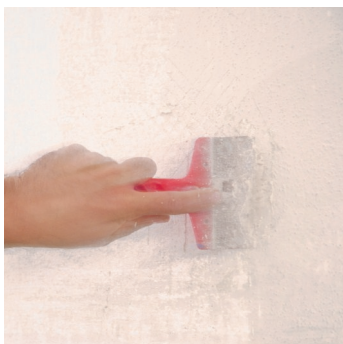
Obr.2 Odstranění nesoudržných vrstev.
