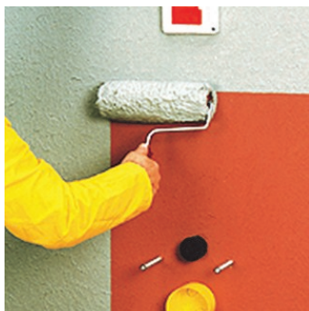
Obr.3a Provedení hydroizolačního nátěru ve 2 vrstvách válečkem.
