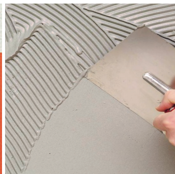
Obr.3b Provedení hydroizolačního nátěru ve 2 vrstvách nerezovým hladítkem.
