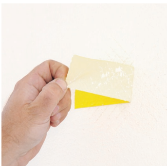
Obr.1 Příp. zkouška přídržnosti podkladních vrstev.
