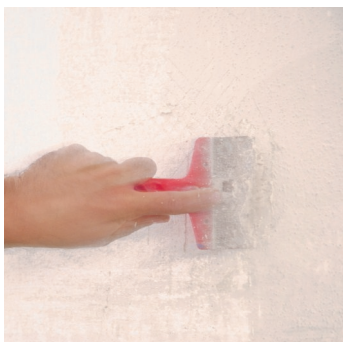
Obr.2 Odstranění nesoudržných vrstev a penetrace podkladu.
