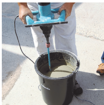
Obr.3 Namíchání materiálu pomocí míchadla nebo m-tec duo-mixu.
