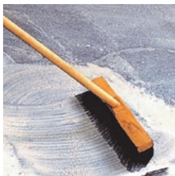
Obr.2 Podklad zpenetrovat předepsanou penetrací.
