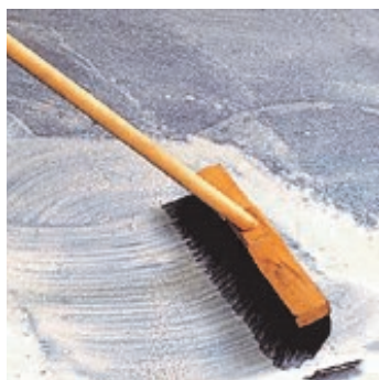
Obr.2 Podklad zpenetrovat předepsanou penetrací.
