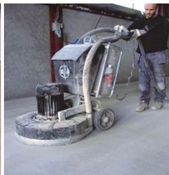
Obr.4 Obroušení povrchu
