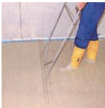
Obr.3 Vibrování potěru.
