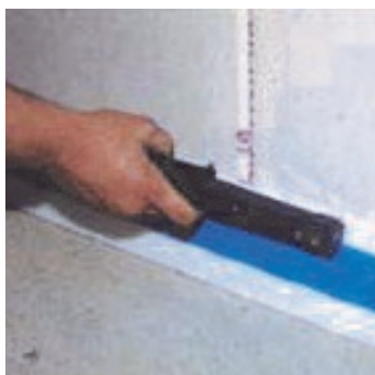
Obr.1 Osazení okrajových pásků.
