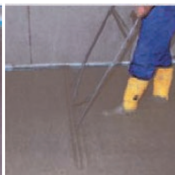
Obr.4 Vibrování potěru vibrační tyčí.
