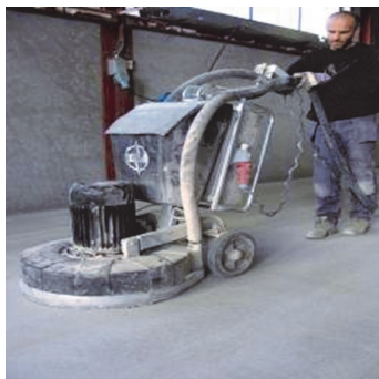
Obr.1 Podklad připravit předepsaným způsobem
