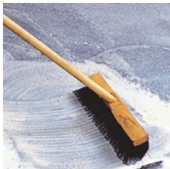
Obr.2 Podklad zpenetrovat předepsanou penetrací.
