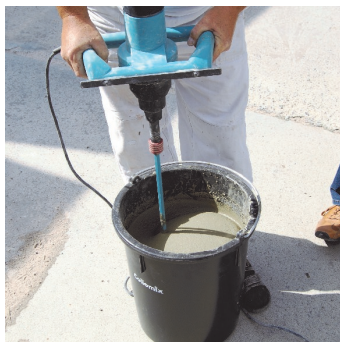
Obr.3 Namíchání materiálu pomocí míchadla, m-tec duo-mixu, nebo m-tec SMP
