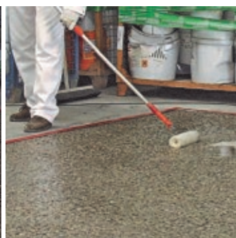
Obr.4 Následně nátěr sjednotit válečkem, který nepouští vlas.
