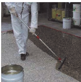
Obr.3 Nátěr rovnoměrně rozdělit na podklad stěrkou z mechové gumy.
