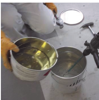
Obr.1 Složku A promíchat, přidat do ní složku B a míchat 2 - 3 minuty.
