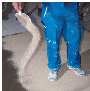
Obr.5 Druhý nátěr vydatně posypat křemičitým pískem pro vytvoření adhezivního můstku.
