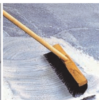
Obr.4 Hotový nátěr rovnoměrně rozdělit na podklad intenzivně a vydatně vetřít měkkým koštětem do podkladu, tak aby nevznikaly louže.
