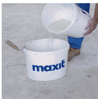
Obr.2 Do nádoby nalít maxit floor 4716 a předepsané množství vody.
