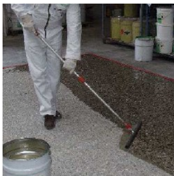
Obr.3 Nátěr rovnoměrně rozdělit na podklad houbovou stěrkou.
