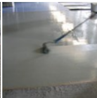
Obr.4 Následně nátěr sjednotit válečkem, který nepouští vlas. Při tom se musí váleček silně přitlačovat.
