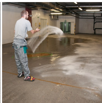
Obr.3 V případě potřeby čerstvou penetrací posypat křemičitým pískem.
