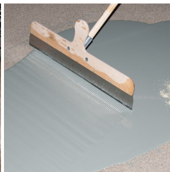
Obr.4 Po vytvrdnutí penetrace nepřichycený písek odsát a nanést polyuretanový povrch maxit floor 4753 ozubenou nebo rovnou stěrkou, v závislosti na požadované tloušťce vrstvy.
