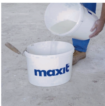
Obr.2 Do nádoby nalít maxit floor 4790 a předepsané množství vody.
