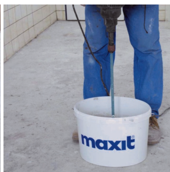
Obr.3 Materiál míchat tak dlouho až vznikne homogenní směs.
