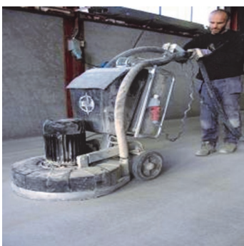
Obr.1 Podklad připravit předepsaným způsobem.
