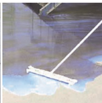
Obr.4 Hotový nátěr rovnoměrně rozdělit na podklad intenzivně a vydatně vetřít stěrkou z mechové gumy, tak aby nevznikaly louže.
