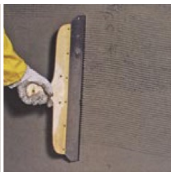
Obr.3 Odvzdušnění omítky rakletovou špachtlí.
