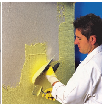
Obr.3 Nanesení omítky nerezovým hladítkem.
