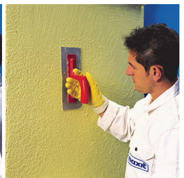
Obr.4 Strukturování povrchu plastovým hladítkem.
