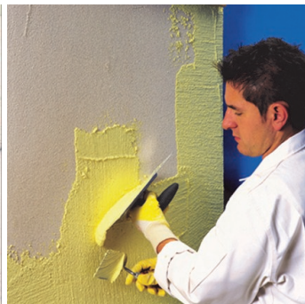
Obr.3 Nanesení omítky nerezovým hladítkem.
