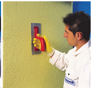
Obr.4 Strukturování povrchu plastovým hladítkem.
