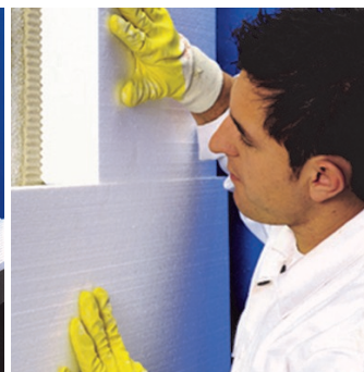
Obr.3 Přilepení desky.
