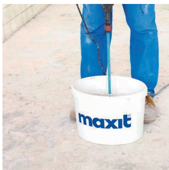
Obr.1 Namíchání malty pomocí míchadla.
