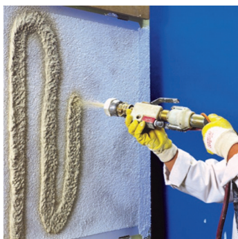
Obr.1a Nanášení lepidla nástřikem přímo na podklad.
