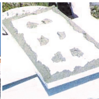
Obr.1b Nanášení lepidla ručně na izolační desky.
