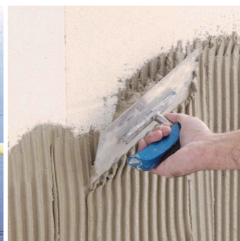
Obr.2b Nanášení armovací stěrky na izolační desky ručně.
