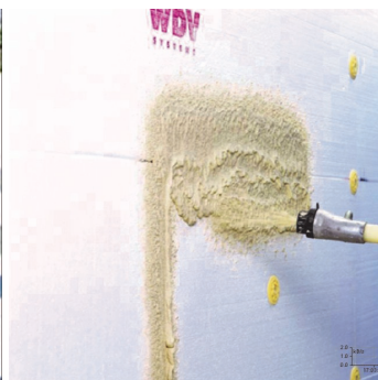
Obr.2a Nanášení armovací stěrky na izolační desky nástřikem.
