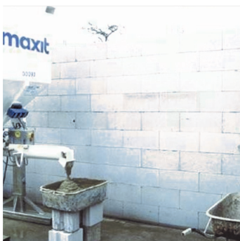
Obr.1a Namíchání malty pomocí kontinuální míchačky.
