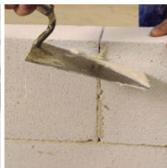
Obr.3 Pokládání cihelných bloků a začištění spár.
