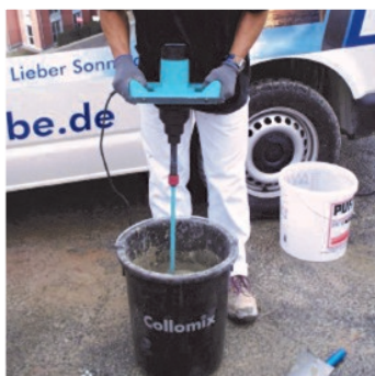
Obr.1b Namíchání malty pomocí elektrického míchadla.
