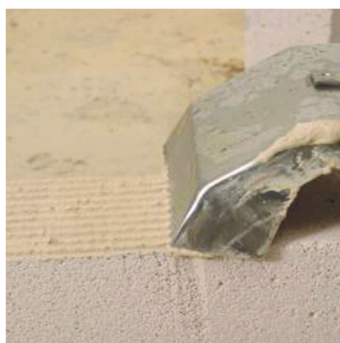
Obr.2 Nanášení zdicí malty na zdivo.
