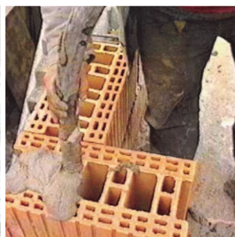
Obr.3 Pumpování zdicí malty přímo na zdivo nebo do připravené nádoby.
