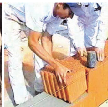
Obr.4 Pokládání cihelných bloků.
