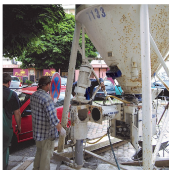
Obr.2 Namíchání malty pomocí m-tec SMP.
