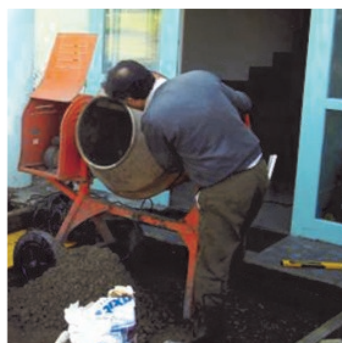
Obr.1b Namíchání malty pomocí bubnové míchačky z pytlů.
