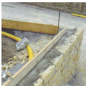
Obr.2 Nanášení zdicí malty na zdivo.
