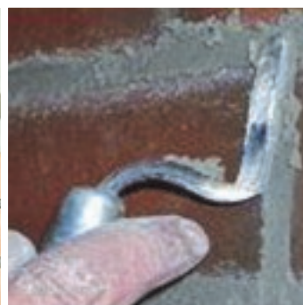
Obr.3 Po ztuhnutí vyhlazení spár.
