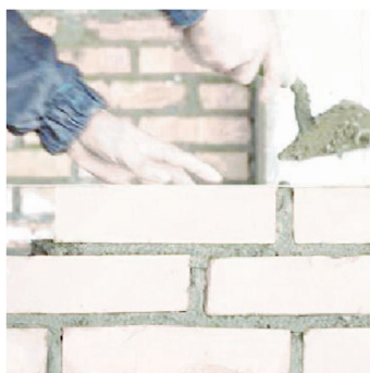
Obr.2 Nanášení zdicí malty na zdivo a pokládání cihel.
