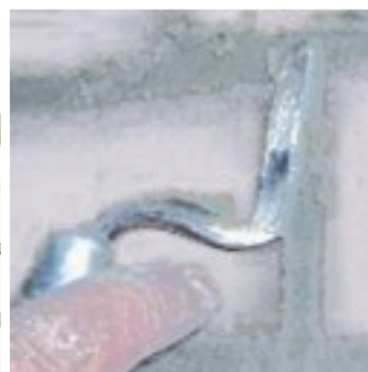
Obr.3 Po ztuhnutí vyhlazení spár.
