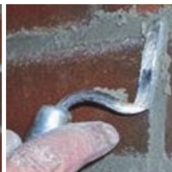
Obr.4 Vyhlazení spár a po ztuhnutí ometení koštětem.
