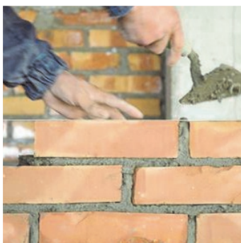
Obr.1 Vyzdění zdiva, vyčištění a namočení spár.
