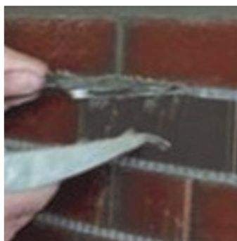
Obr.3 Nanášení spárovací malty do spár.
