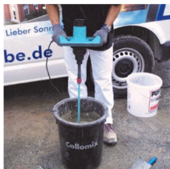
Obr.2 Namíchání malty pomocí kontinuální míchačky nebo míchadla.
