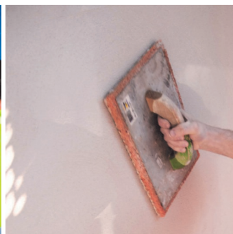
Obr.4 Vyhlazení povrchu houbovým nebo filcovým hladítkem.
