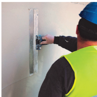
Obr.3 Urovnání povrchu fasádní špachtlí.
