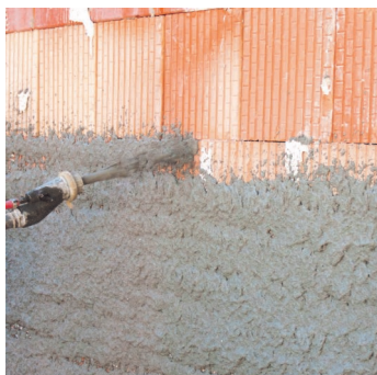
Obr.1 Nástřik omítky pomocí omítačky.
