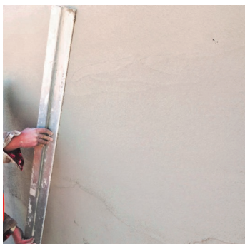
Obr.2 Urovnání povrchu "h-latí".
