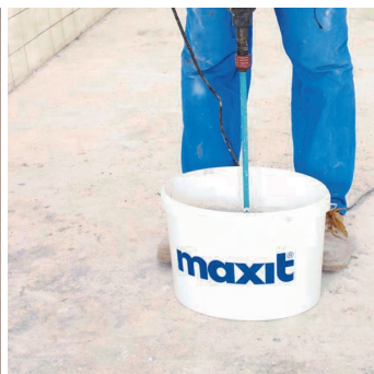
Obr.3 Promíchání penetračního nátěru.
