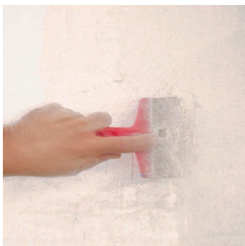
Obr.2 Odstranění nesoudržných vrstev.
