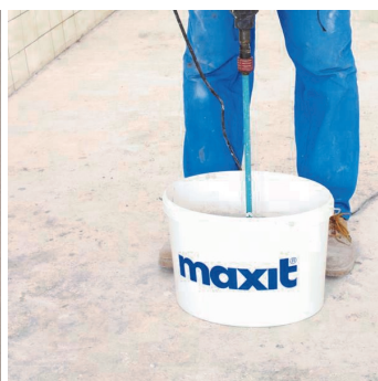
Obr.3 Promíchání penetračního nátěru.
