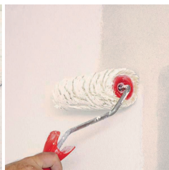
Obr.4 Provedení penetračního nátěru v 1 nebo 2 vrstvách.
