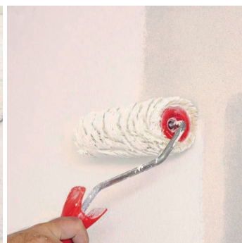
Obr.4 Provedení penetračního nátěru v 1 nebo více vrstvách.
