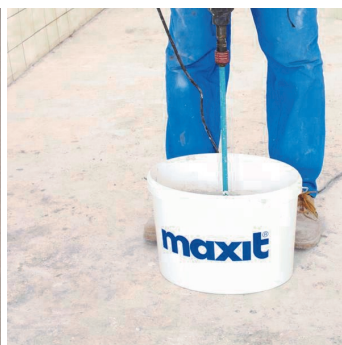
Obr.3 Promíchání penetračního nátěru.
