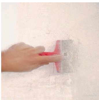
Obr.2 Odstranění nesoudržných podkladních vrstev.
