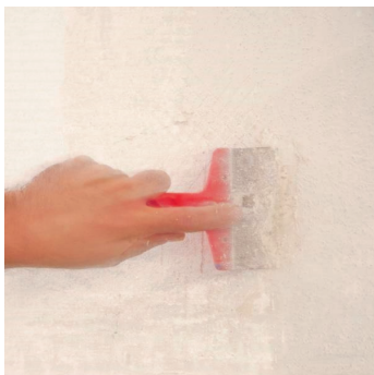
Obr.2 Odstranění nesoudržných vrstev.
