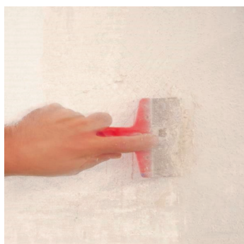
Obr.2 Odstranění nesoudržných vrstev.
