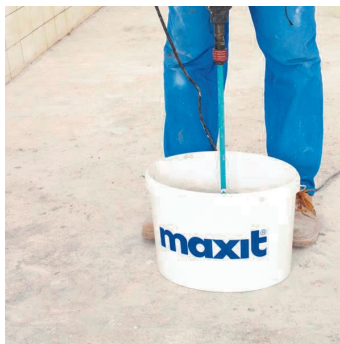
Obr.3 Promíchání penetračního nátěru.
