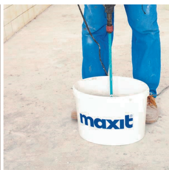
Obr.3 Promíchání penetračního nátěru.
