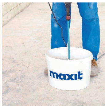
Obr.3 Promíchání penetračního nátěru.
