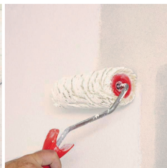
Obr.4 Provedení penetračního nátěru v 1 nebo více vrstvách.
