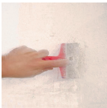
Obr.2 Odstranění nesoudržných podkladních vrstev.
