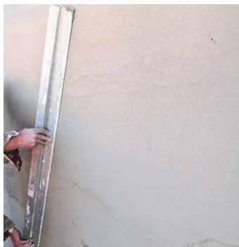
Obr.3 Urovnání povrchu.
