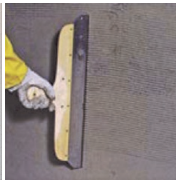
Obr.4 Zdrsnění povrchu.
