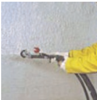
Obr.2 Nástřik omítky pomocí omítačky nebo ze síla.
