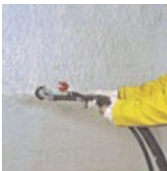
Obr.2 Nástřik omítky pomocí omítačky nebo ze síla.
