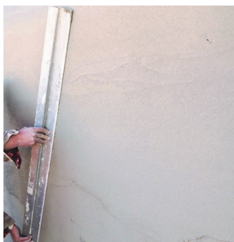
Obr.3 Urovnání povrchu.
