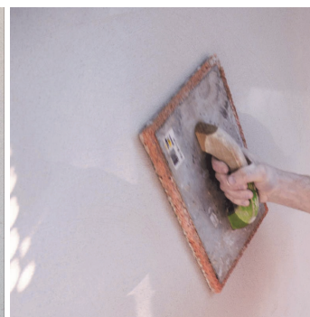
Obr.4 Vyhlazení povrchu houbovým nebo filcovým hladítkem.
