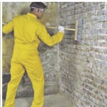
Obr.3 Odstranit nečistoty z povrchu ometením.
