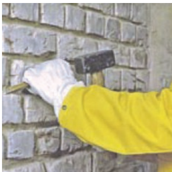
Obr.2 U starého zdiva vyškrábat spáry.
