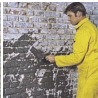
Obr.4 Nanášení prohozu ručně nebo strojně rovnoměrně s cca 50% pokrytím zdiva.
