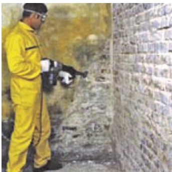
Obr.1 Podklad připravit předepsaným způsobem, osekát staré omítky.
