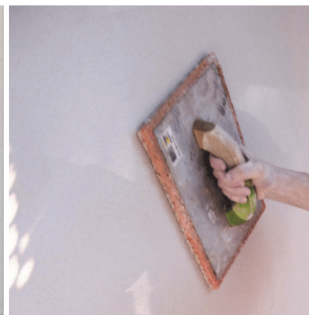
Obr.4 Vyhlazení povrchu houbovým nebo filcovým hladítkem.
